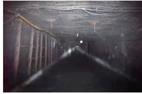
图 6 现场留巷照片
